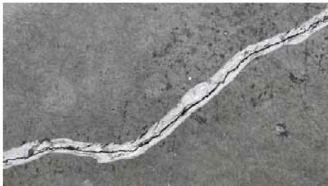
Figuur 3: V-vormige groef in de scheur.
