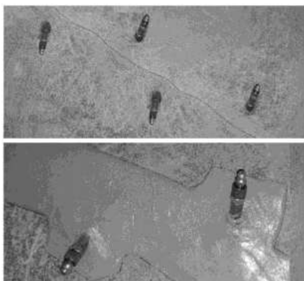
Figuur 1: busvormige nippels geplaatst rond de scheur en afgedicht met een aangepaste epoxylijm uit het MasterInject gamma.
