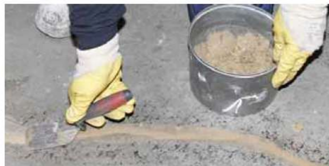
Figuur 6: nivelleer het scheuroppervlak met behulp van aangepaste MasterInject / MasterFlow mortel.
