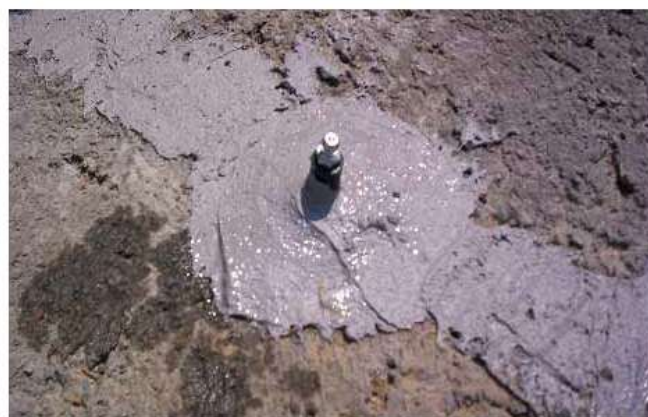
Figuur 2: de opbouwnippel en de scheur afdichten met aangepast MasterInject hechtmiddel.
